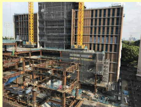
工事現場写真（平成29年6月撮影）
