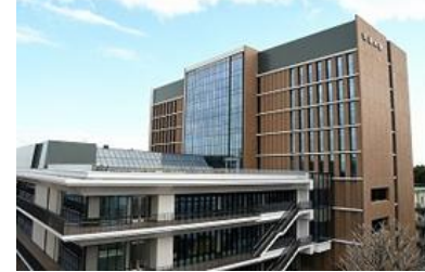
上：本部棟／下：3号館「種月館」
