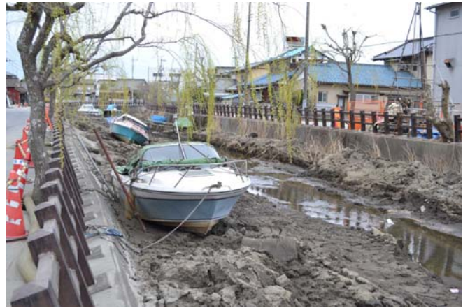
6 佐原小野川下流域の噴砂による被害 2011.4.3 河床から土砂が噴出,ボートは土砂の上に乗上げた。
