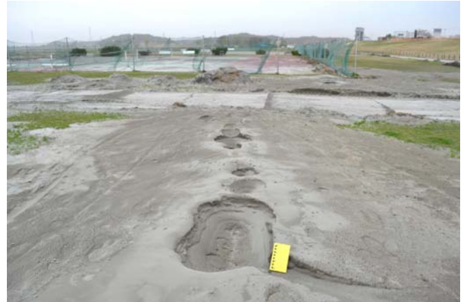
8 佐原利根川河川敷緑地(右岸)の噴砂現象 2011.4.8 河川敷のテニスコートにも被害が及んだ。
