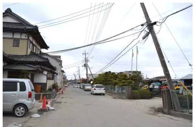
4 佐原粉名口の住宅地の液状化による被害 2011.4.3
