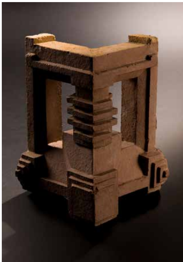
帝国ホテル二代目本館で使われていた、コーナー用のテラコッタ 製作：帝国ホテル煉瓦製作所 大正 6 ～ 10（1917 ～ 1921）年 画像提供；INAX ライブミュージアム 撮影：梶原敏英
