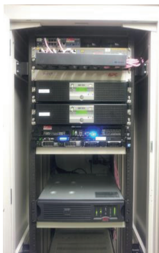
専用サーバラック
